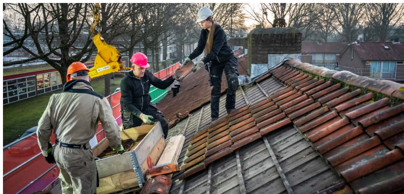
Bij de renovatie van een woonwijk werden 100.000 stuks dakpannen teruggenomen om te worden hergebruikt als grondstof voor straatsteenproductie
